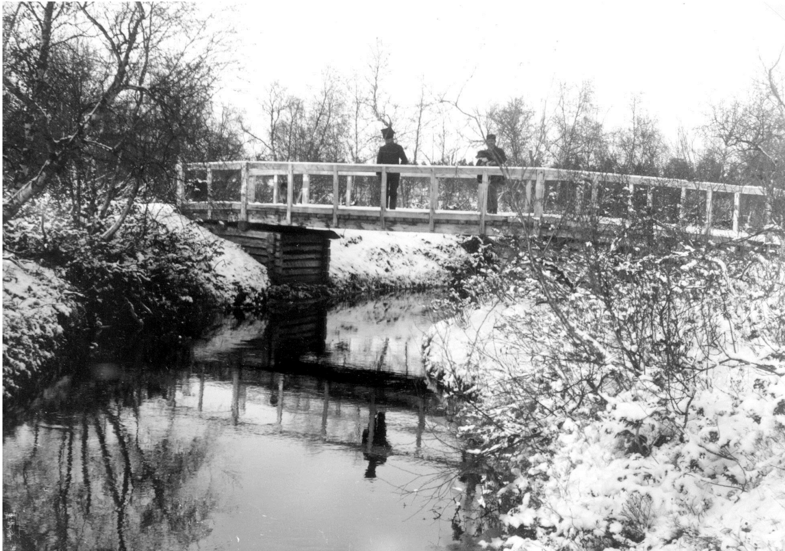
Prospektorin tiellä rakennettu Tankajoen silta vuonna 1903. Sillan kannella virkakuntaa ja paikallinen työntekijä.
