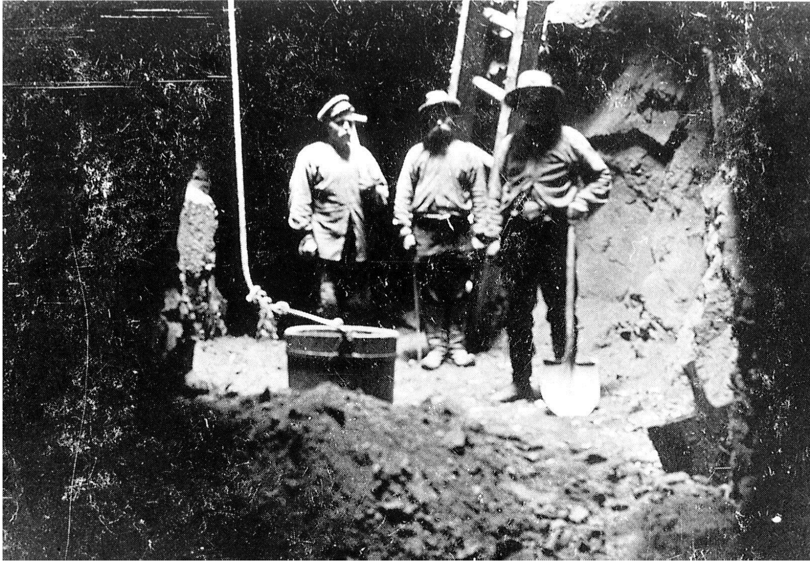
Luton kaivoskuilu maan alla n. 40 metrin syvyydessä
