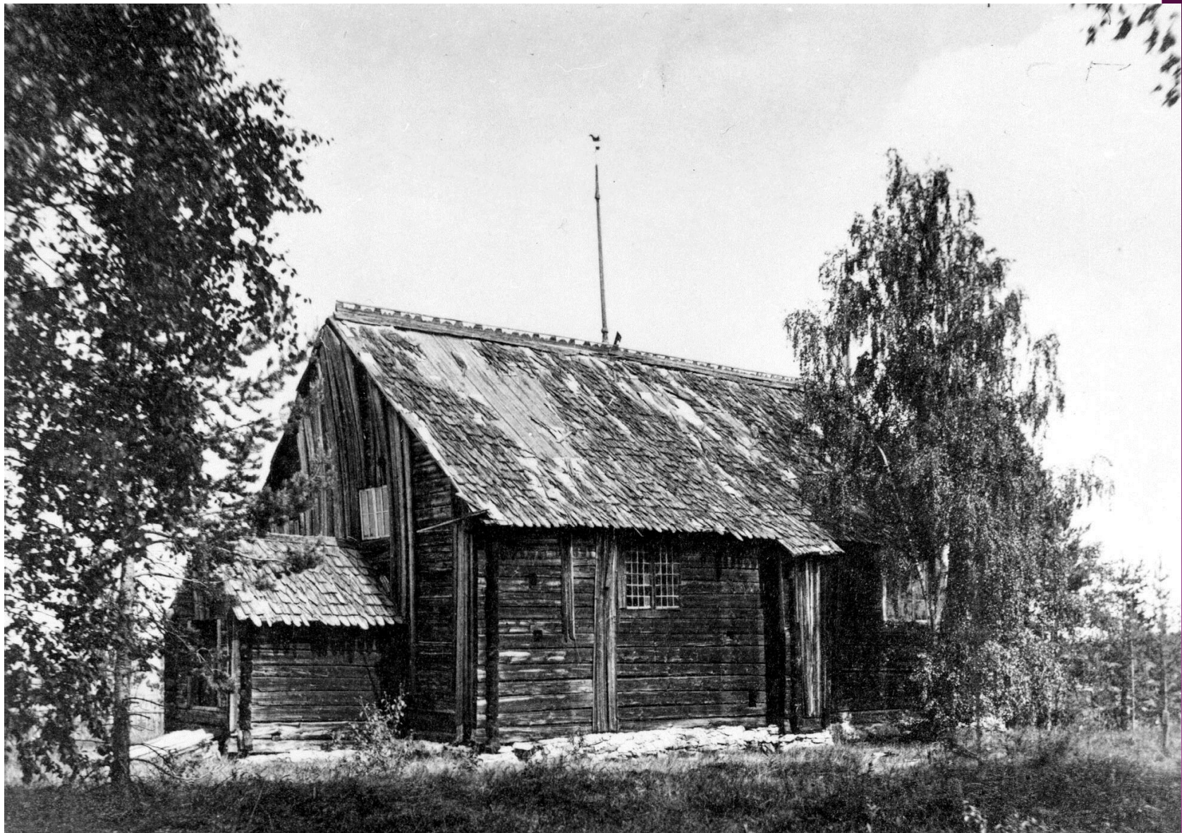
Sodankylän vanha puukirkko ennen peruskorjausta.
